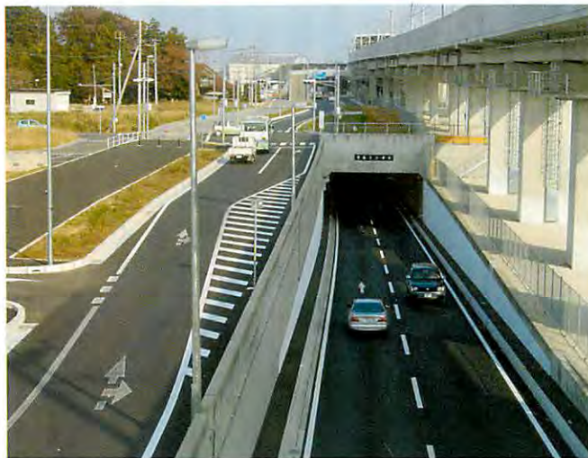
昨年8月に開通した守谷トンネル下り線
