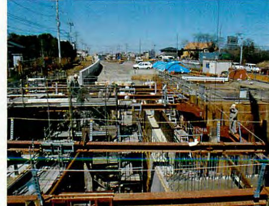
順調に進む乙子交差点の立体化工事
