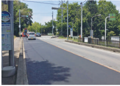
高野小改修後
