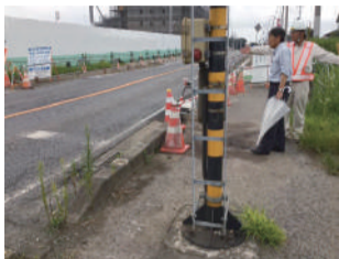
踏切脇の歩道整備
